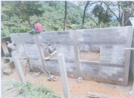
Foto 6: Tallado de columnas.
