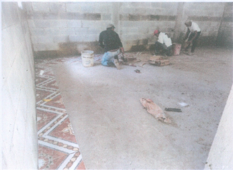
Foto 3: Colocación de Piso ceramico.
