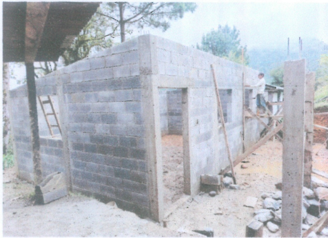
Foto 2: Proceso de mejoramiento del aula.
