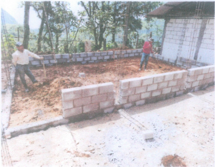
Foto 5: iniciando el levantamiento de block.
