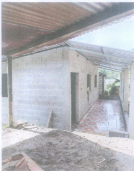
Foto1: Proceso de mejoramiento del aula.
